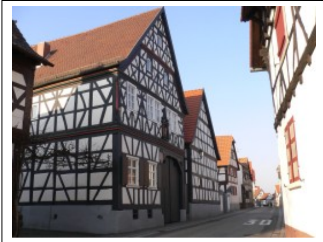
Kulturzentrum „Zehnhaus“ im Hinterstädtel
